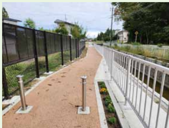
下堰幹線用水路（豎川目）（施工後）
