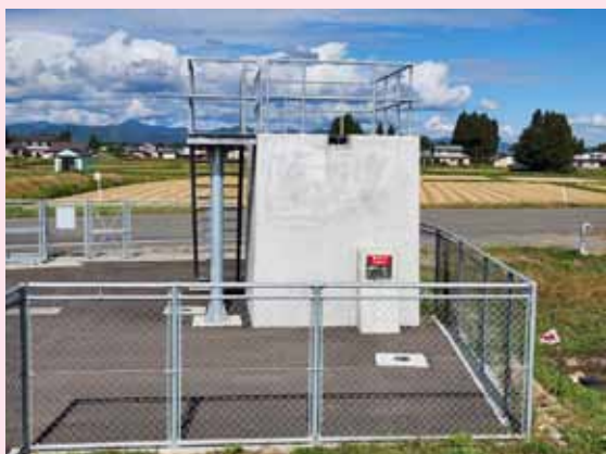
中笹間配水槽（完成）
