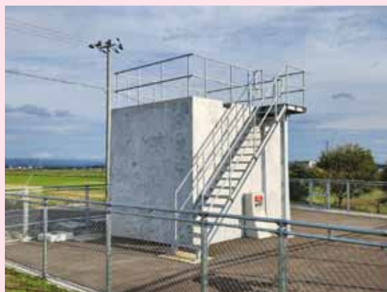
千刈配水槽（完成）
