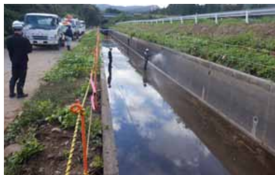
工事の実施状況（R6年9月） 表面被覆工事前の既設水路の洗浄
