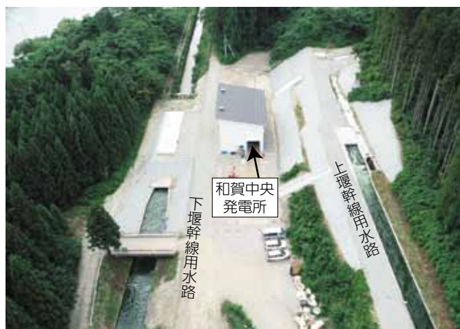
小水力発電施設
