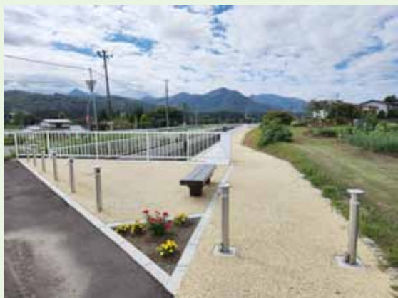
下堰幹線用水路（横川目）（施工後）
